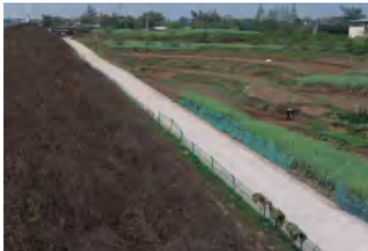
K10+200 处改移道路 (2023.3)
