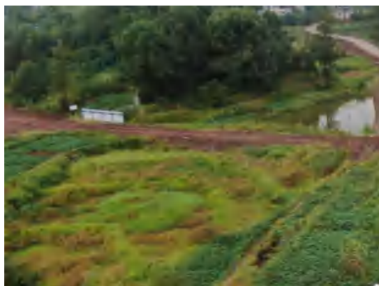
K15+600 弃渣场施工便道 (2021.5)
