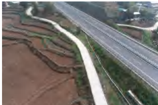
K41+800 处改移道路 (2023.3)
