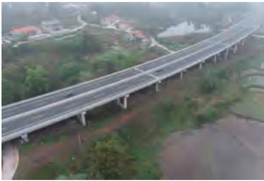
楼子山大桥施工便道(2022.3)
