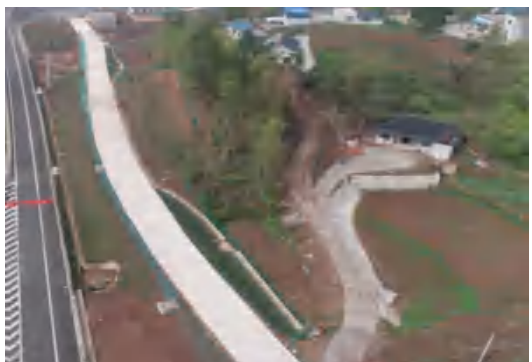
K34+400 处改移道路 (2023.3)
