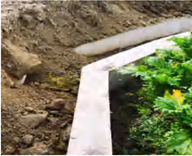
完成清理后的排水沟
