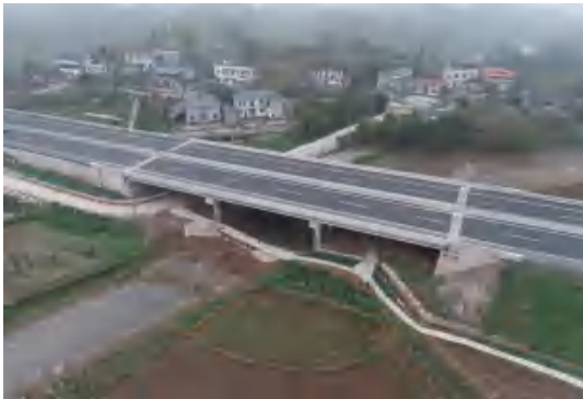
踏水河中桥施工便道 (2023.3)
