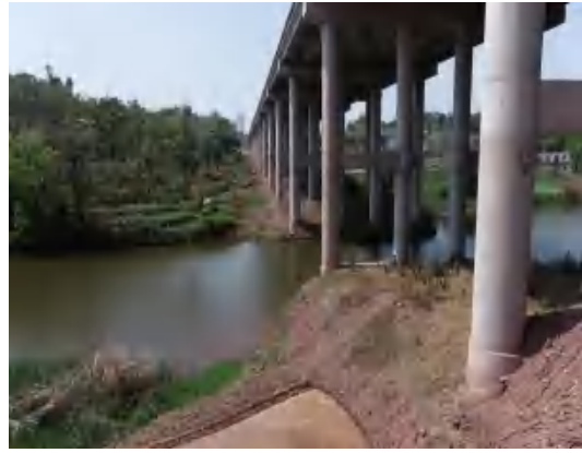
观音山大桥施工便道 (2022.3)
