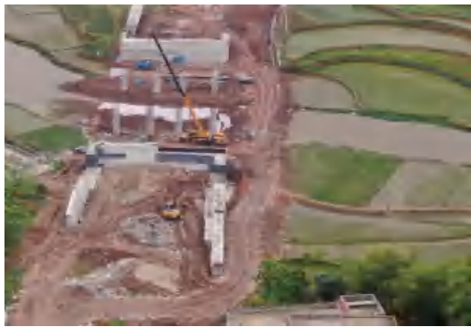
踏水河中桥施工便道 (2021.5)
