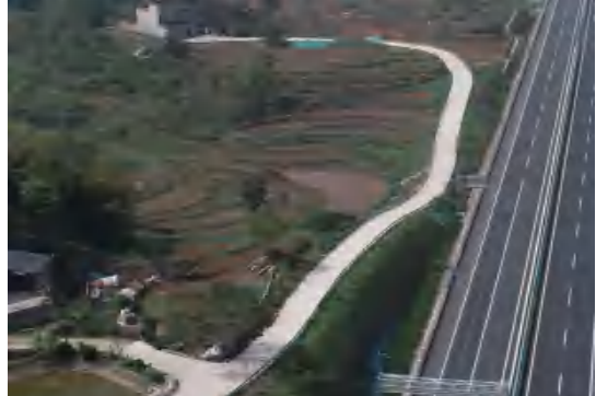
K14+800 处改移道路 (2023.3)
