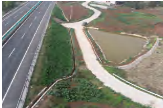
K32+900 处改移道路 (2023.3)
