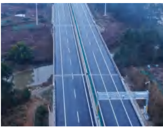
龙溪河中桥施工便道 (2023.3)
