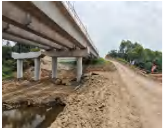
龙溪河中桥施工便道 (2021.5)
