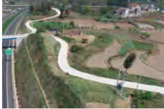
K4+300 处改移道路 (2023.3)
