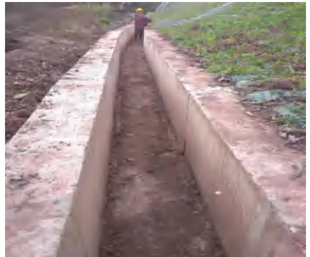
排水沟盖板铺装
