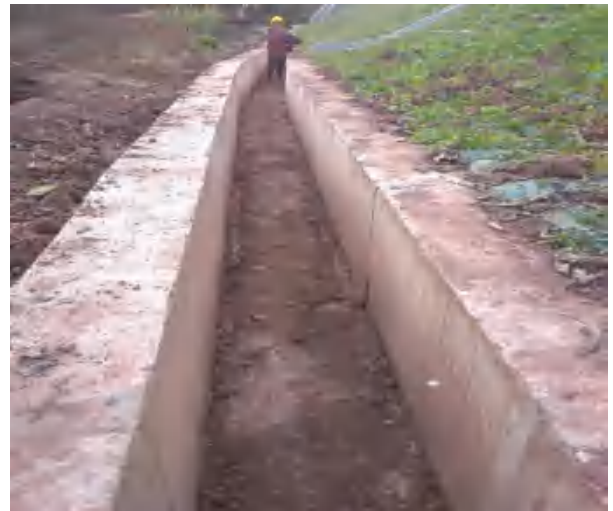
排水沟盖板铺装
