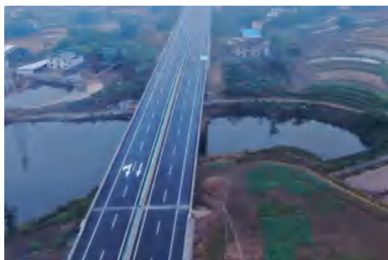
大水坝大桥施工便道 (2022.12)
