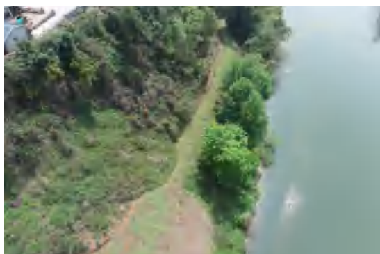
濂溪河大桥施工便道 (2023.3)
