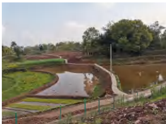
K15+600 弃渣场施工便道 (2022.3)
