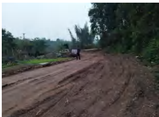
滩子口大桥施工便道 (2021.5)
