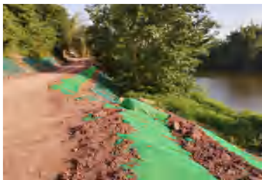
濂溪河大桥施工便道 (2021.5)
