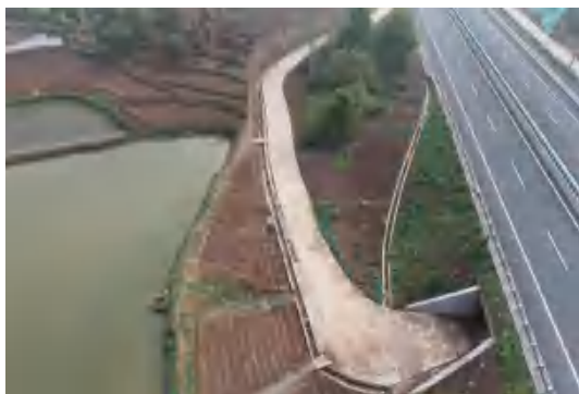
K30+940 处改移道路 (2023.3)
