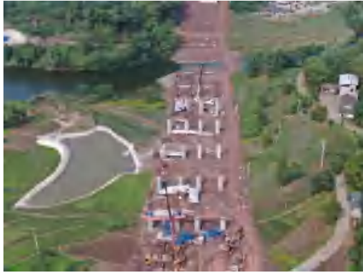
观音山大桥施工便道 (2021.5)
