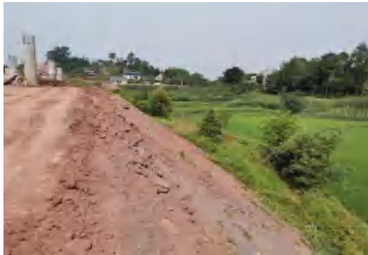
楼子山大桥施工便道(2021.6)
