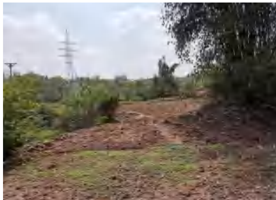
滩子口大桥施工便道 (2023.3)
