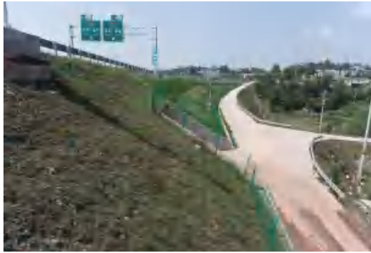
K0+800 处改移道路 (2023.3)
